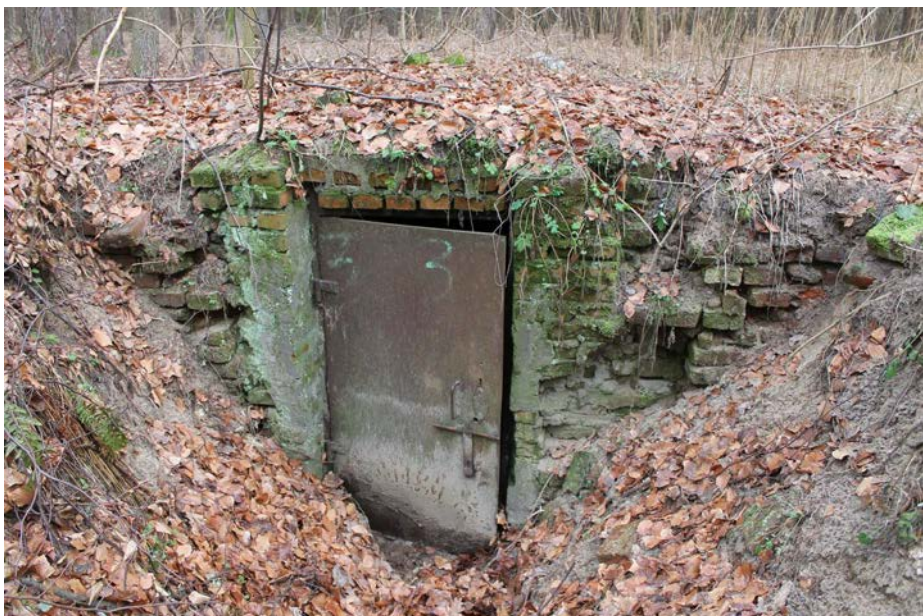
Pozostałości fundamentów leśniczówki w Krzywej Palce .
