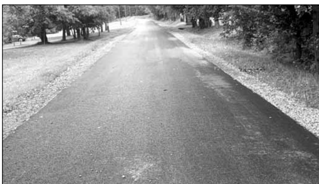
Nowa nawierzchnia asfaltowa została wykonana na drodze gminnej nr 914 i 2113 w Błażowej Dolnej oraz odcinku drogi gminnej nr 997 w Nowym Borku.
