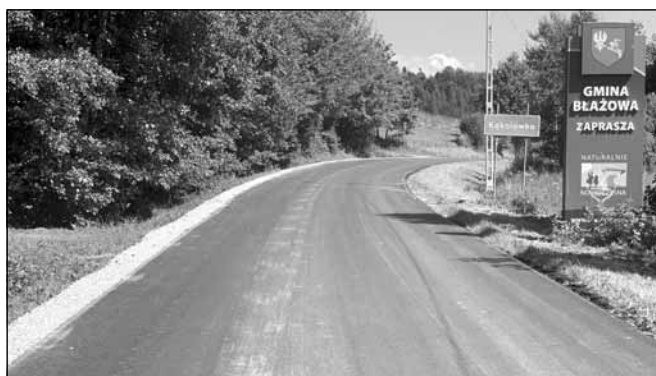
Nowa nawierzchnia asfaltowa została wykonana na drodze gminnej 1190 w Kąkolówce (dofinansowanie z funduszu sołeckiego) oraz na odcinku drogi powiatowej.
