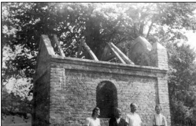
Budowa kaplicy. Wilczak 1950 r.
