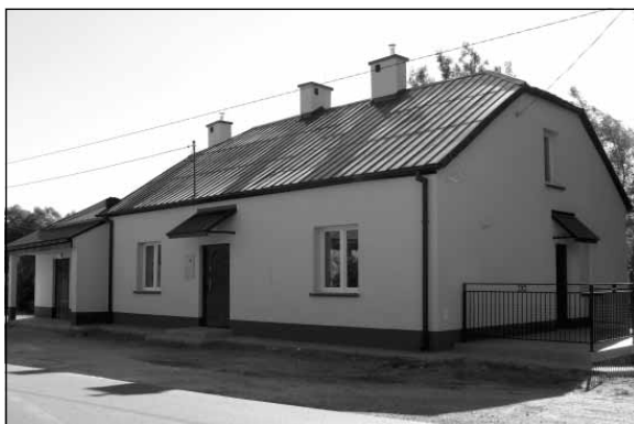
Budynek świetlicy w Błazowej Górnej.
