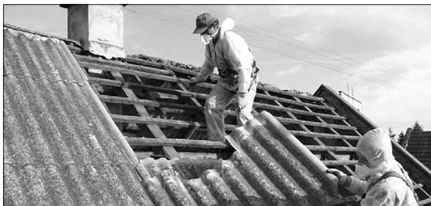
Usuwanie płyt azbestowych z dachu.
