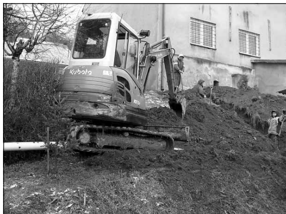
Budowa gazociągu. Fot. J. Heller
