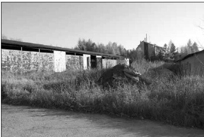
Obecny stan budynków.
