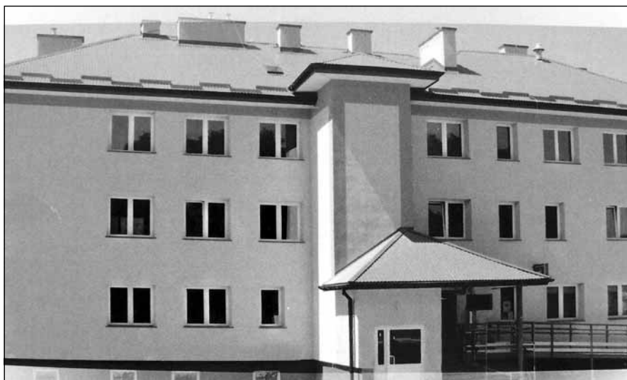
Budynek przychodni po remoncie.
