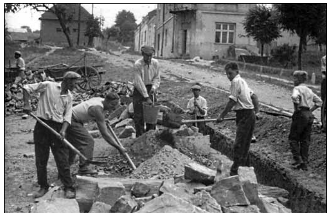
Prace przy błażowskim kościele.
