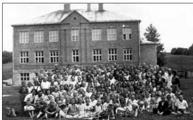
Zdjęcia pokazują etapy budowy szkoły.
