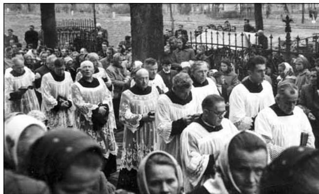
Na zdjęciu widoczne ogrodzenie z bram wjazdowych od strony plant.
