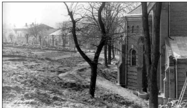
Teren wyrównano w celu równomiernego rozłożenia sił nacisku gruntu.
