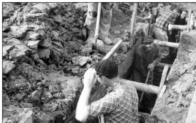
Wykopy pod nowe ogrodzenie.
