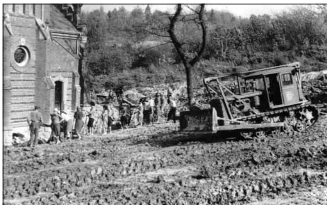
Późniejsze prace przy pomocy spychacza.
