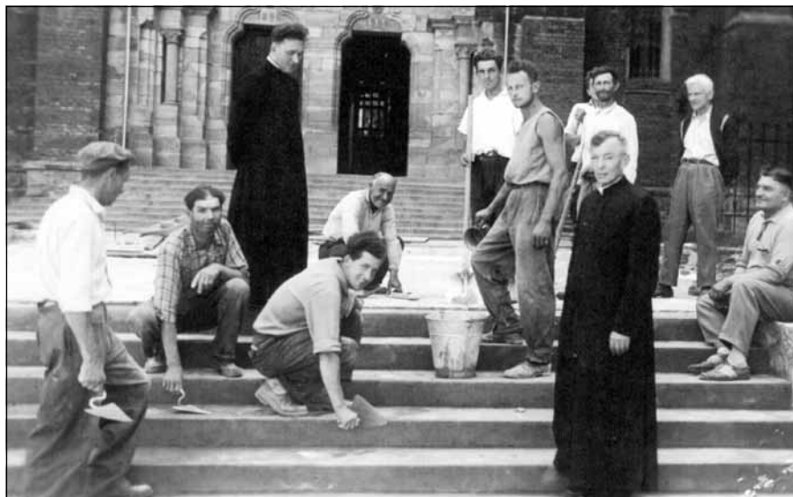
Prace przy kościele parafialnym, początek lat 60. XX w. Pracują kielnią od lewej Roman Kulasa, Edward Chlebek, stoi ks. Adolf Kowal, Józef Kulasa, ks. Józef Kruczek i inni.
