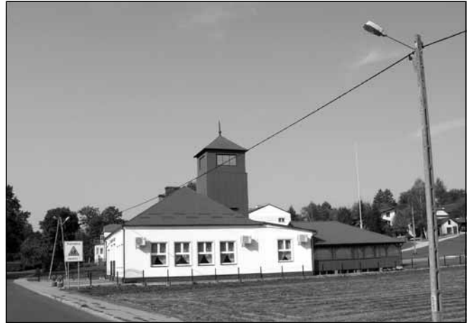
Rozbudowa oświetlenia ulicznego w Białce.
