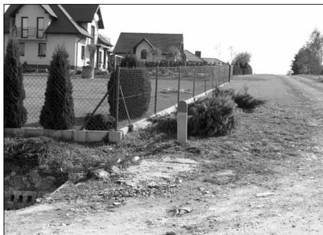
Budowa sieci wodociągowej rozdzielczej dla osiedla Dalnica w miejscowości Futoma.
