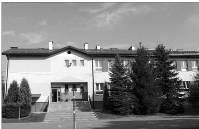
Nadbudowa budynku Szkoły Podstawowej w Białce.
