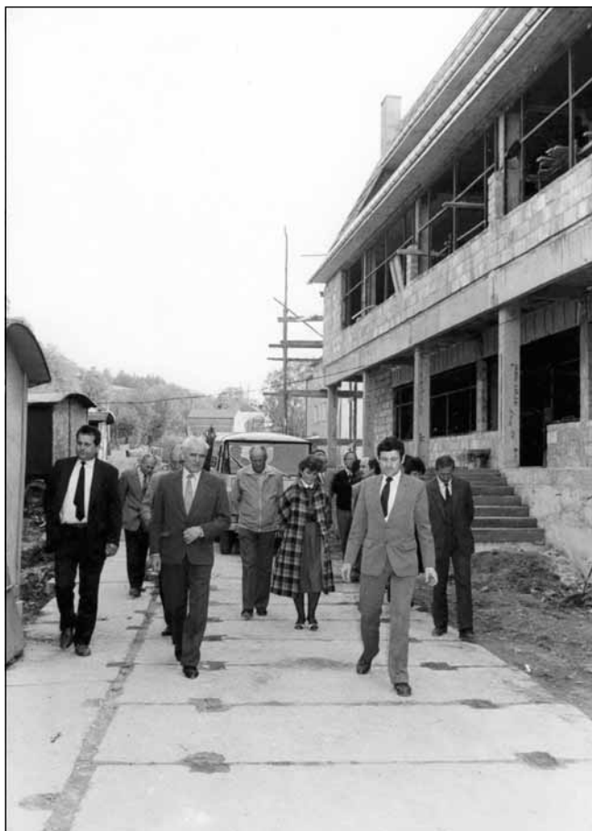
Budowa domu handlowego w Białowej.
