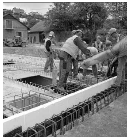
Budowa mostu na Błażową Górą.
