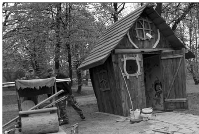
Trwają prace w błażowskim parku.
