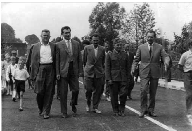
Odbiór nowego mostu koło błazowskiego parku.
