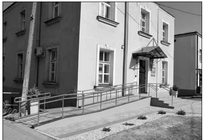
Zakończono prace przed budynkiem Urzędu Miejskiego w Błażowej.
