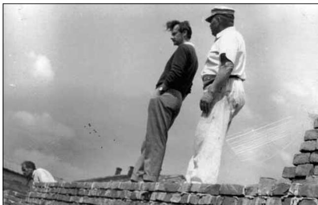
Budowa sali gimnastycznej.
