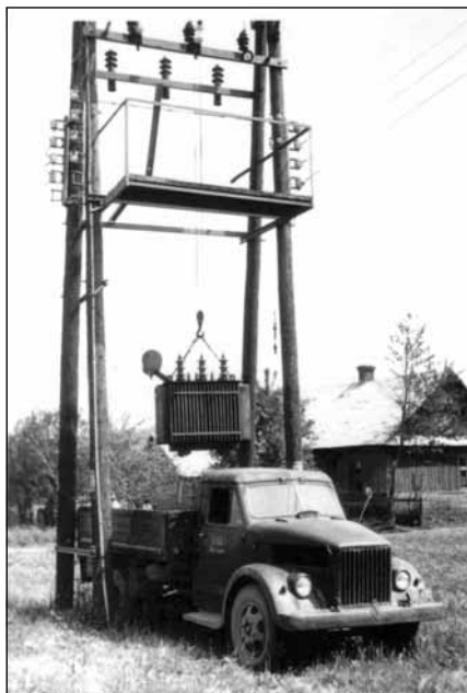
Montaż transformatora.
