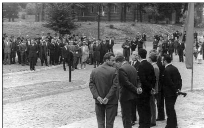
Przygotowanie miejsca pod dworzec autobusowy w Błazowej.
