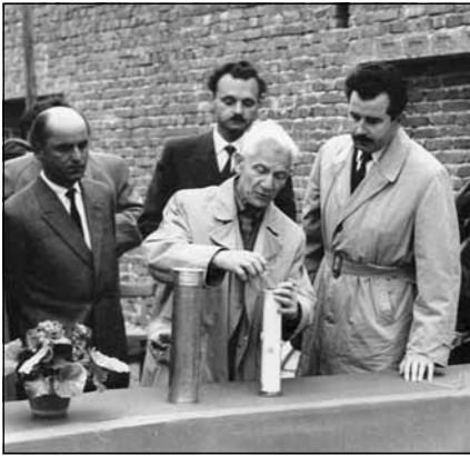
Wmurowanie aktu erekcyjnego szkoły podstawowej.
