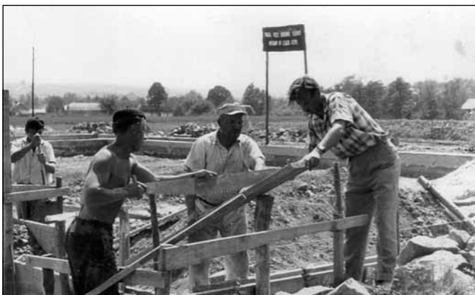
Szalowanie fundamentów pod budynek szkoły w czynie społecznym.
