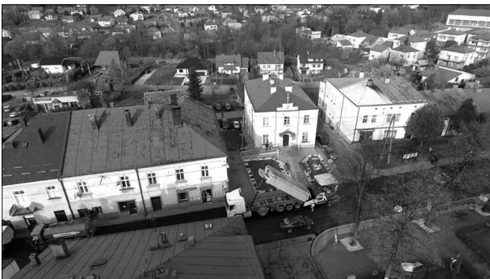
Prace przy nowej nawierzchni drogi w Błażowej z lotu ptaka.
