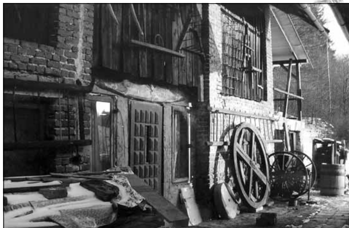
Remont budynku stodoły.
