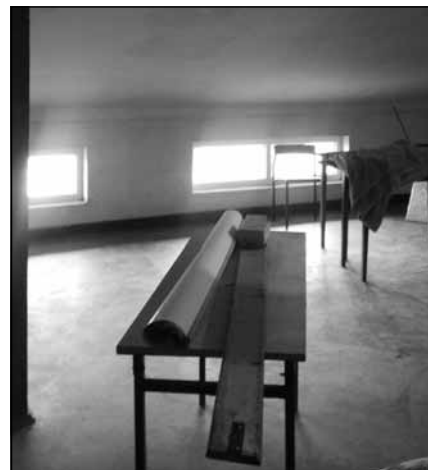
Sala muzeum po ociepleniu w trakcie malowania.
