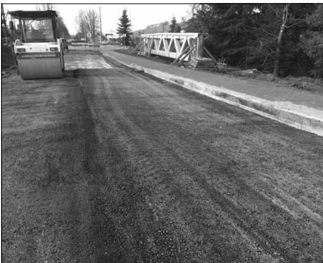
Dobiegły końca prace związane z przebudową mostu na drodze powiatowej w Borku Starym. Nowy most o wymaganej szerokości i jednostronnym chodniku zastąpił stary i wąski, który powodował utrudnienia w ruchu.
