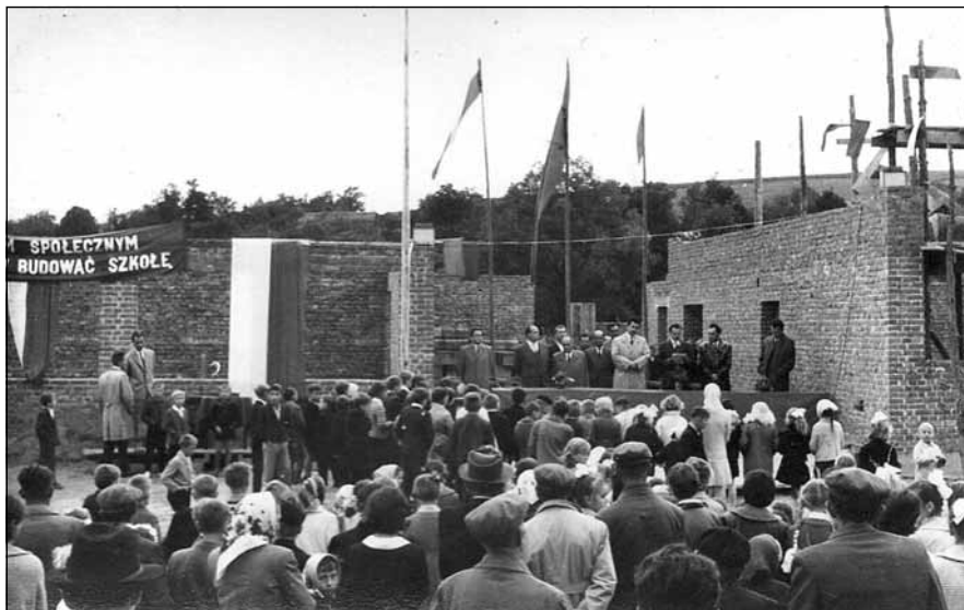
Budowa szkoły podstawowej w Błażowej.
