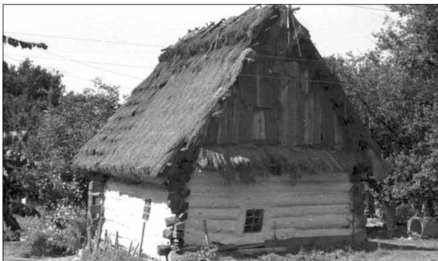
Chata widoczna jest na mapie Nowego Borku.
