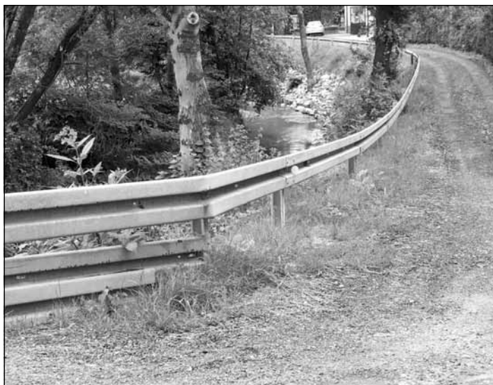
Ochronne bariery drogowe zamontowane.
