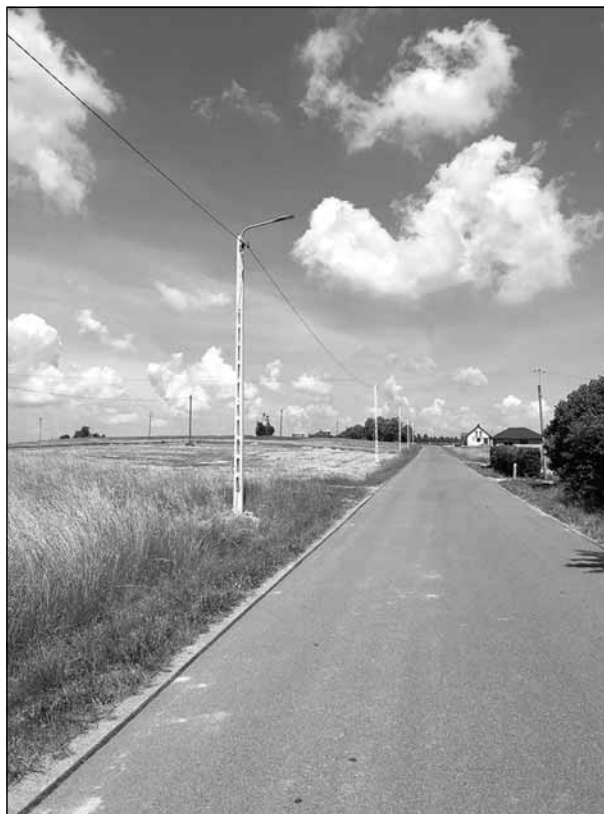
Trwają prace przy montażu nowych lamp oświetlenia ulicznego. Do tej pory zamontowano kilkanaście z nich, natomiast główna tego typu inwestycja nastąpi jesienią, gdzie przy drodze wojewódzkiej w Nowym Borku zostanie zainstalowanych ponad 50 lamp. Działania te zwiększą bezpieczeństwo użytkowników korzystających z tych dróg.
