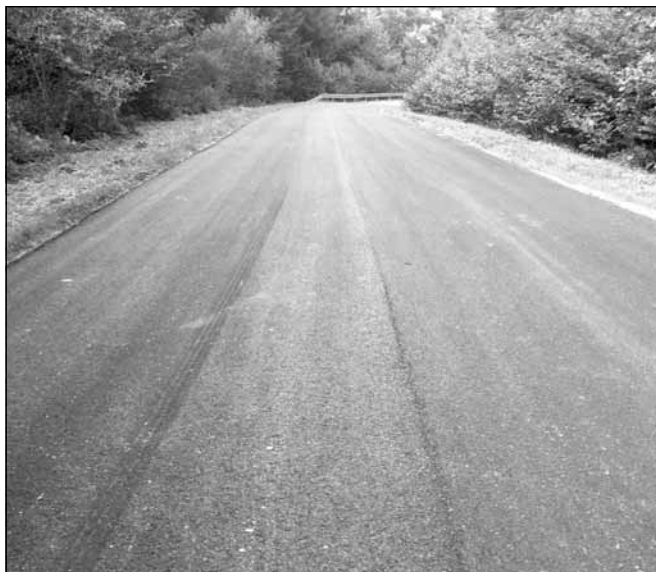
Na najbardziej zniszczonym odcinku drogi powiatowej w Kąkolówce zostały uzupełnione ubytki masy bitumicznej, a na odcinku około 300 metrów została położona nowa nawierzchnia asfaltowa.
