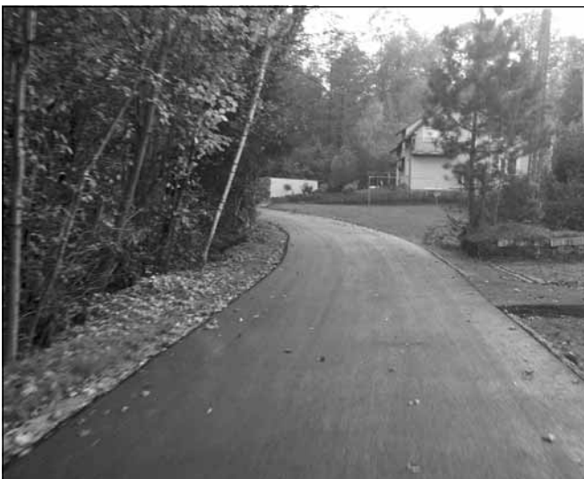
Zakończyła się przebudowa 350 metrowego odcinka drogi gminnej Białka Szele.
