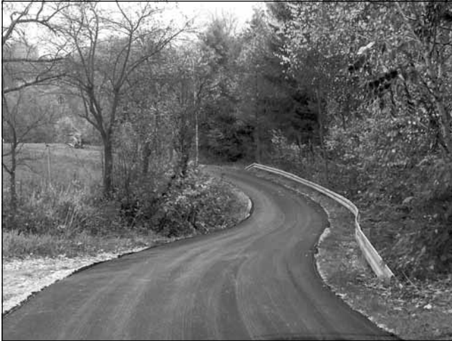
Dobiegła końca przebudowa drogi gminnej Lecka Góra, podczas której na 250 metrowym odcinku położono nową nawierzchnię asfaltową.
