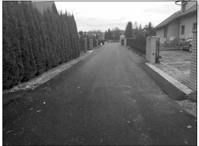
Dobiegły końca prace przy przebudowie drogi gminnej w Błażowej Dolnej. Podczas inwestycji wykonano ponad 200 metrów nawierzchni asfaltowej oraz 100 metrów nawierzchni kamiennej.
