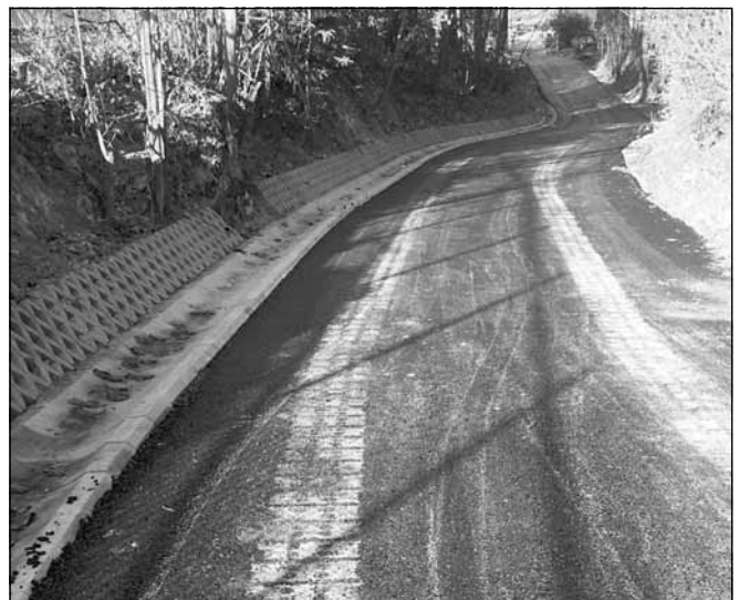
W Piątkowej została zakończona przebudowa drogi gminnej „Nad Spółdzielnią koło Husa”.
