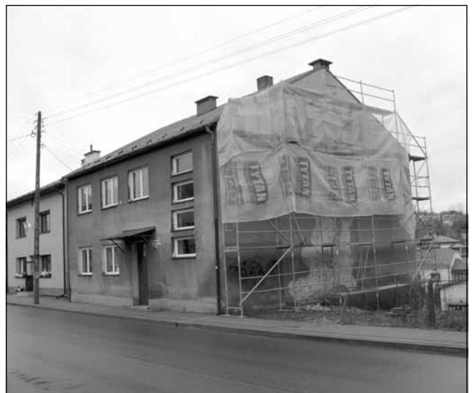
Trwają prace termomodernizacyjne błażowskiej biblioteki.
