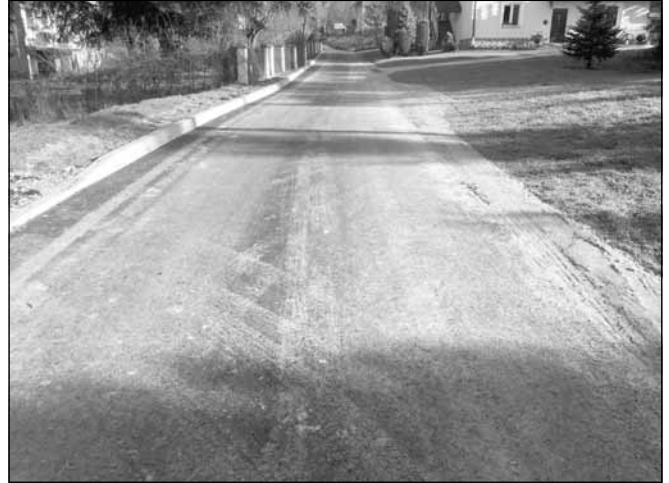
Dobiegła końca przebudowa drogi gminnej bocznej Lutaka w Błażowej.
