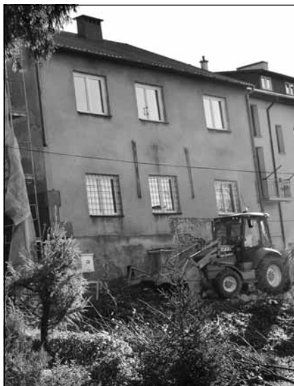
Prace rozpoczęto w październiku rozbiórką baraku przylegającego do budynku biblioteki.
