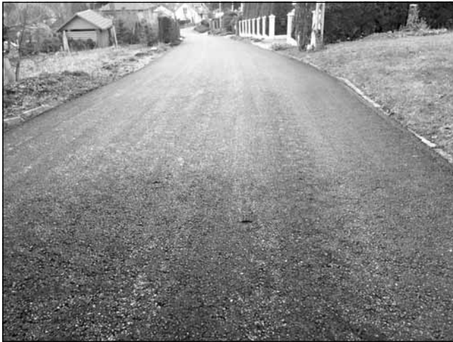
Na brakującym 300-metrowym odcinku ulicy Jagiellońskiej w Błażowej została położona nowa nawierzchnia.
