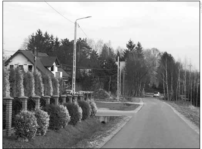
Na drodze gminnej Nowy Borek – Budy zostało zainstalowanych 6 nowych lamp oświetlenia ulicznego.
