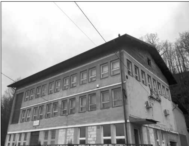
Zakończyła się budowa dachu na Domu Ludowym w Piątkowej – pierwszy etap przebudowy tego budynku.
