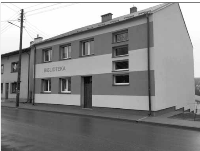
Kończą się prace związane z termomodernizacją budynku Miejsko-Gminnej Biblioteki Publicznej w Błażowej.
