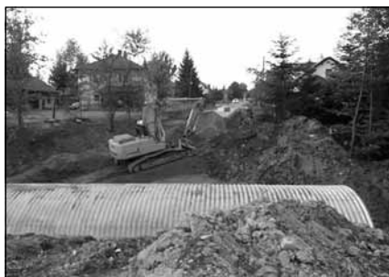
Trwa budowa mostu na drodze powiatowej Nr 1416 relacji Tyczyn – Nowy Borek – Błażowa.
