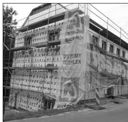
Mieszkańcy Białki doczekali się remontu Wiejskiego Ośrodka Zdrowia. Całkowity koszt inwestycji to kwota 677714,74 zł.
