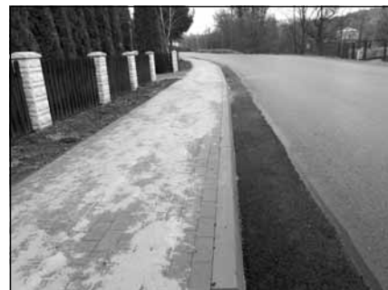
Budowa chodników w miejscowościach Lecka, Białka, Błażowa Górna, Błażowa Dolna.
