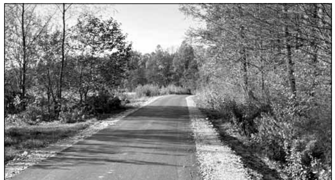
Zakończyła się przebudowa drogi gminnej Nowy Borek – Czerwonki.
