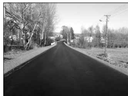
Przebudowa drogi powiatowej Nr 1416R relacji Tyczyn – Nowy Borek – Błażowa.
