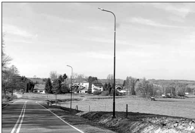
Zakończył się powykonawczy odbiór końcowy oświetlenia ulicznego przy drodze wojewódzkiej w Nowym Borku.
