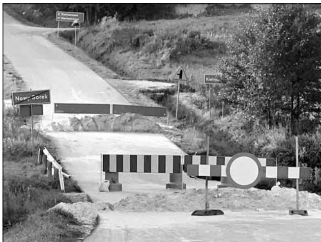
Zakończyły się procedury związane z przebudową mostu na drodze powiatowej na „Krółkę”. Wkrótce rozpoczną się prace inwestycyjne. Wszystko wskazuje na to, że tegoroczny termin realizacji zostanie dotrzymany.
