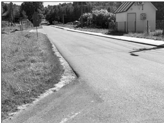
Rozpoczyna się budowa odcinka chodnika wraz z przejściem dla pieszych przy drodze powiatowej w Piątkowej. Lokalizacja przejścia przy Szkole Podstawowej zapewni uczniom bezpieczną drogę na zajęcia.
