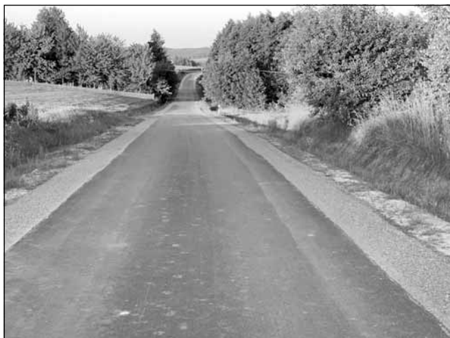
Zakończyła się przebudowa odcinka drogi gminnej Błażowa Dolna – Wola Błażowska o długości 1 km.
