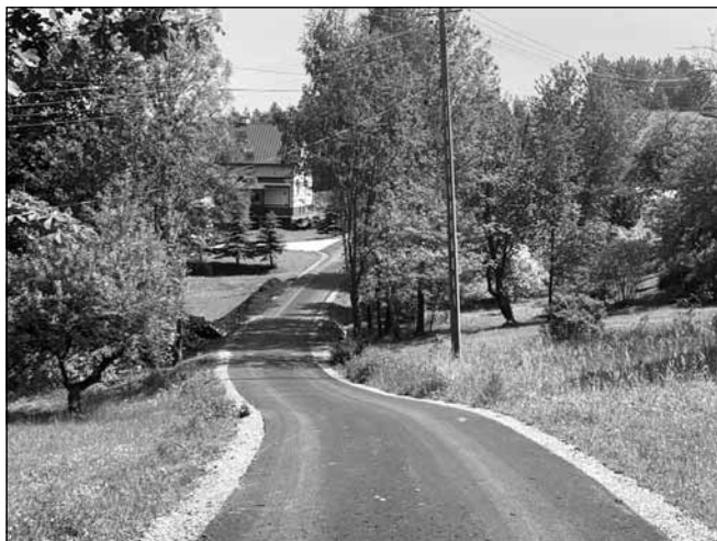
W ramach funduszu sołeckiego zostały przebudowane odcinki dróg w Piątkowej, Białce, Futomie i Lecce, gdzie została położona nowa nawierzchnia asfaltowa wraz z pobocznymi oraz zostały udrożnione fosy.
