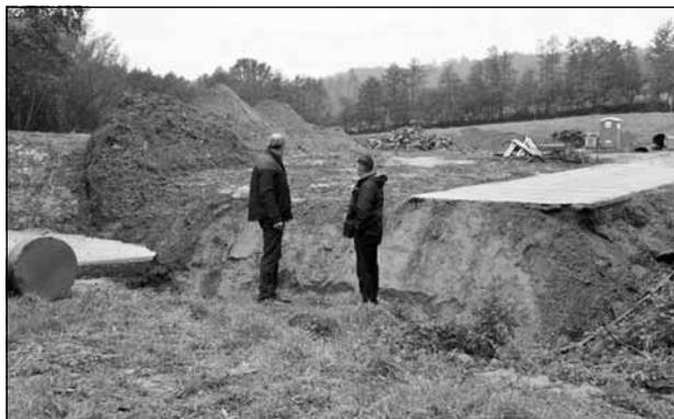
Będzie nowy przepust zniszczony w czerwcowej powodzi na drodze powiatowej NR 1416R.
