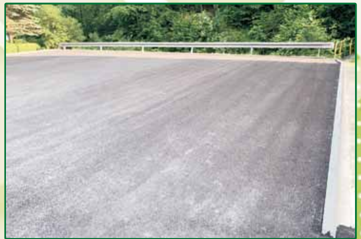
Przebudowa parkingu przy OSP Lecka.
