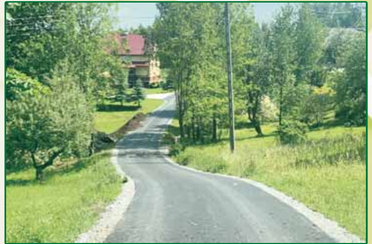
Fundusz sołecki przebudowa drogi gminnej nr 2466 w Futomie.
