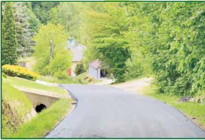
Fundusz sołecki przebudowa drogi gminnej nr 50 w Lecce.
