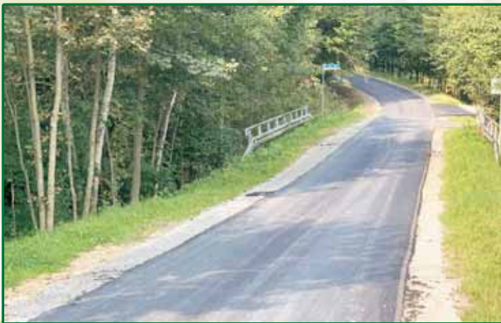
Przebudowa drogi gminnej w Kąkolówce.
