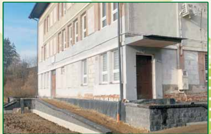
Kolejny etap termomodernizacji Domu Ludowego w Piątkowej: wymiana okien oraz odwodnienie i docieplenie fundamentów .
