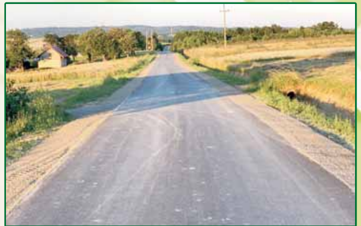
Przebudowa drogi gminnej Błażowa Dolna Wola (FDS).
