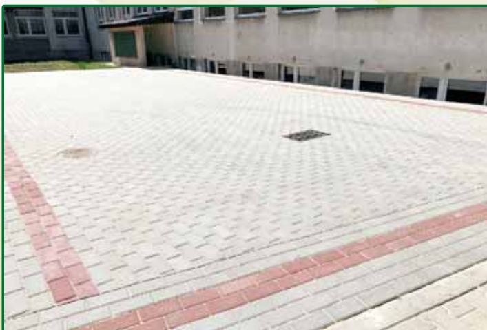
Budowa parkingu przy Zespole Szkół w Błażowej.
