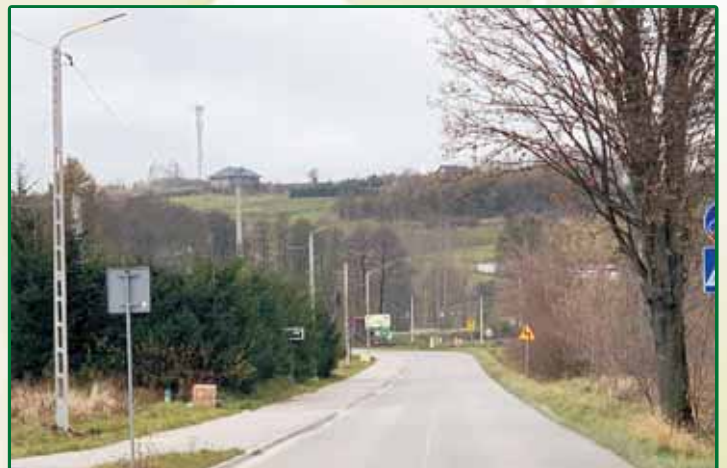
Budowa oświetlenia ulicznego przy drodze powiatowej Błazowa - Piątkowa.
