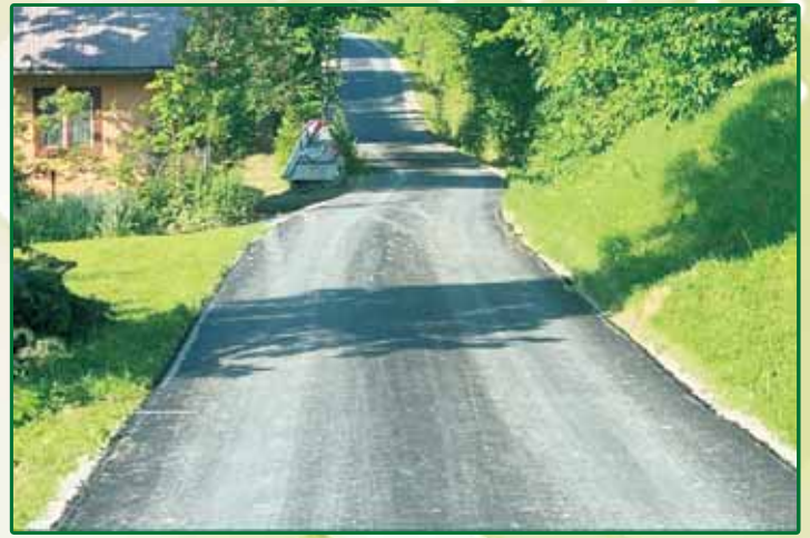
Fundusz sołecki przebudowa drogi gminnej nr 2115 w Piątkowej.
