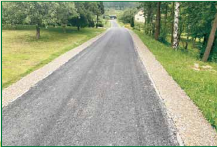
Fundusz sołecki przebudowa drogi gminnej nr 360/1 w Białce.
