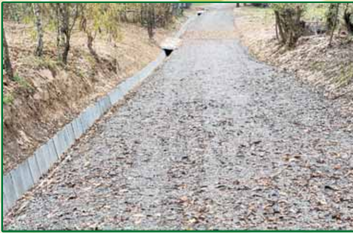
Przebudowa drogi gminnej nr 287 w Błażowej Dolnej (poscaleniowe).
