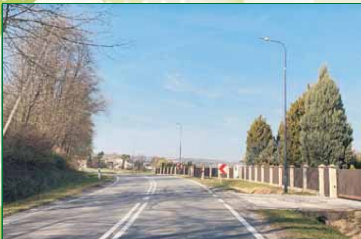
Budowa oświetlenia ulicznego przy drodze wojewódzkiej w Nowym Borku Przyłasku.
