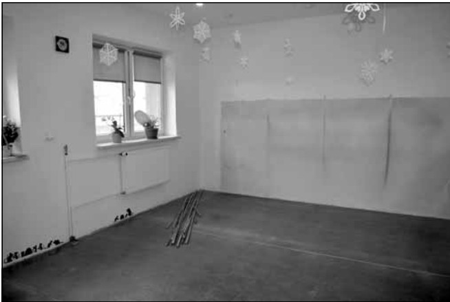
Pomieszczenie przed remontem.
