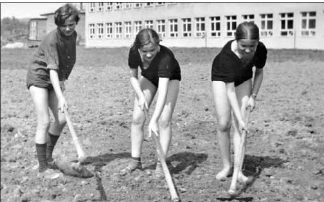
Od lewej: Helena Sowa, Zuzanna Bartoń i Kazimiera Początek – plantowanie terenu za szkołą w Błazowej 1968 r.
