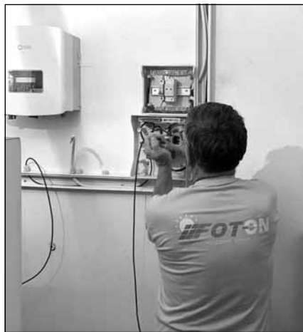
Montaż instalacji elektrycznej.
