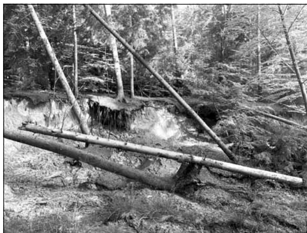
Osuwisko na Mokłuczce.
