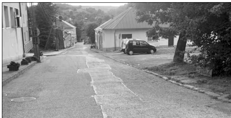
Przebudowa parkingu przy Zakładzie Opieki Długoterminowej i Paliacji w Błażowej.
