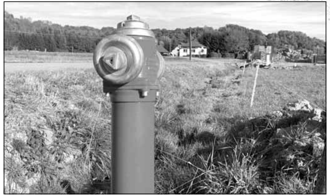
Zakończyła się budowa dwukilometrowego odcinka wodociągu w Nowym Borku – Stawiska.
