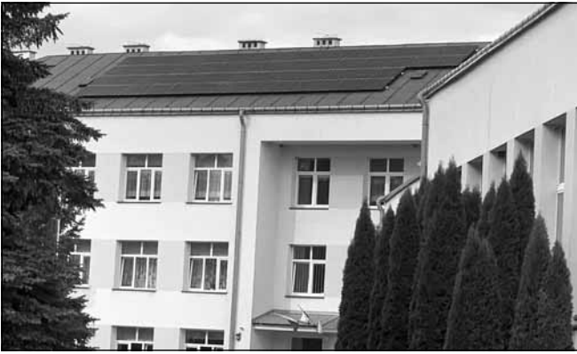
Zakończył się montaż paneli fotowoltaicznych na dachu Szkoły Podstawowej w Błażowej Dolnej.
