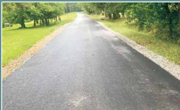
Przebudowa drogi gminnej 447 w Nowym Borku
