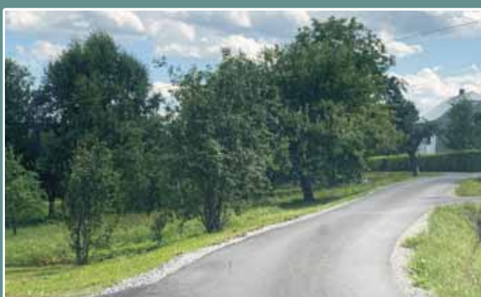
Przebudowa drogi gminnej 1190 w Kąkolówce
