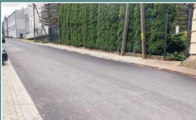
Przebudowa ulicy Piłsudskiego w Błażowej
