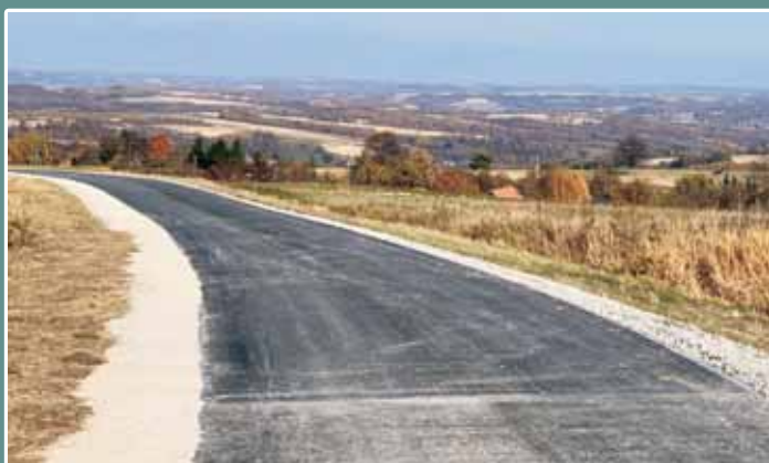
Przebudowa drogi gminnej Kąkolówka Wola
