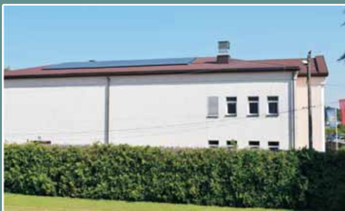
Montaż instalacji fotowoltaicznej na budynku GOK Błażowa
