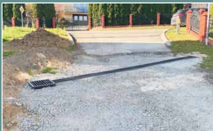
Rozbudowa kanalizacji deszczowej w Błażowej
