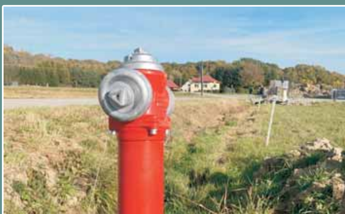
Budowa wodociągu Nowy Borek Stawiska
