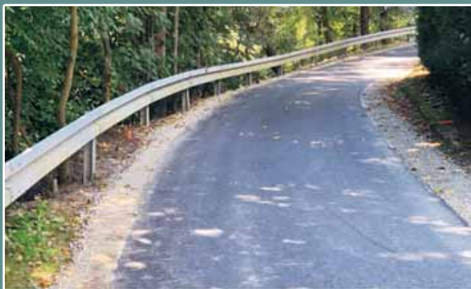
Przebudowa ulicy Rzecznej w Błażowej
