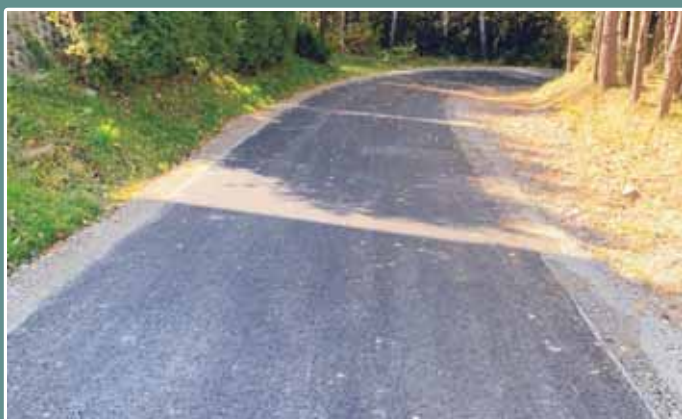
Przebudowa drogi gminnej Futoma Jaworznik
