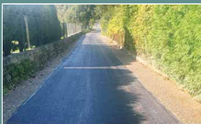
Przebudowa drogi gminnej 840 w Błażowej Górnej
