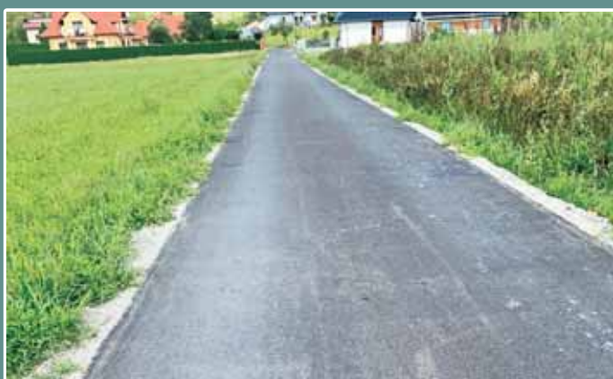
Przebudowa drogi gminnej 914 w Błażowej Dolnej
