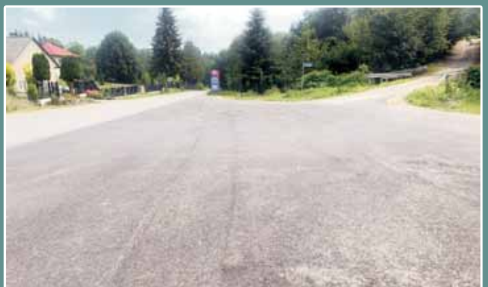
Przebudowa zatoki autobusowej w Lecce
