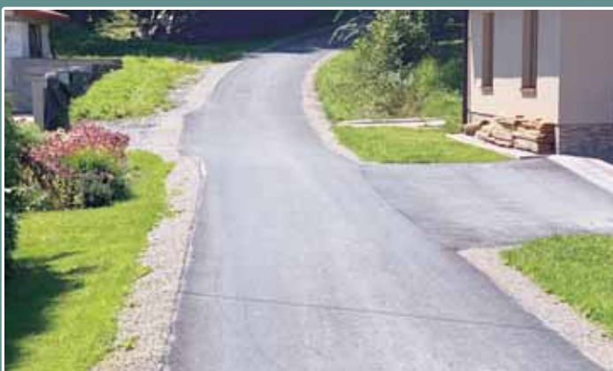
Przebudowa drogi gminnej 460 w Białce
