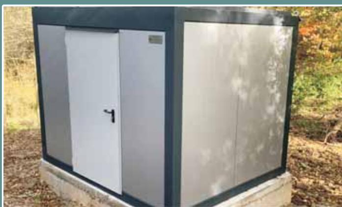
Budowa wodociągu przy ulicy Jagiellońskiej w Błażowej
