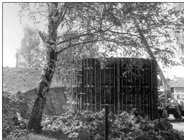
Rozbudowa Stacji Uzdatniania Wody w Błazowej.
