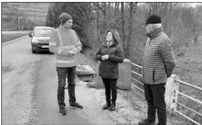
Przegląd techniczny dróg powiatowych.
