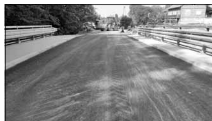
Odbudowa most na potoku „Futomka” w miejscowości Futoma.
