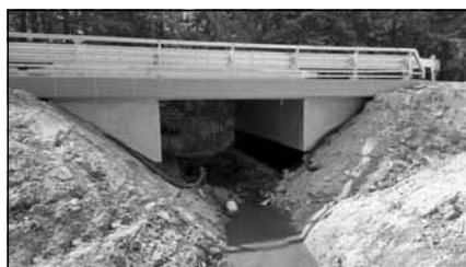
Odbudowa mostu na rzece Piątkówka w Piątkowej. Droga powiatowa do Futomy.
