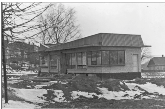
Dworzec PKS w Błazowej - budowa.
