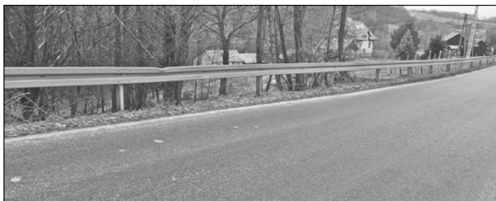
Przepust Kąkolówka „Rola”. Koszt naprawy ok. 34 tys. zł.
