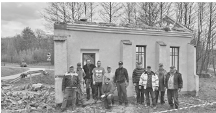
Rozpoczęliśmy pierwszy etap rewitalizacji czyli rozbiórkę.
