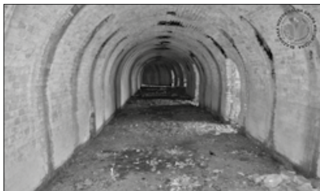
Wkład pieca mieścił ok. 100 000 cegieł.
