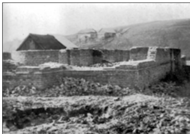
Budowa Domu Ludowego.
