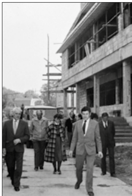
Budowa Domu Handlowego w Błażowej.
