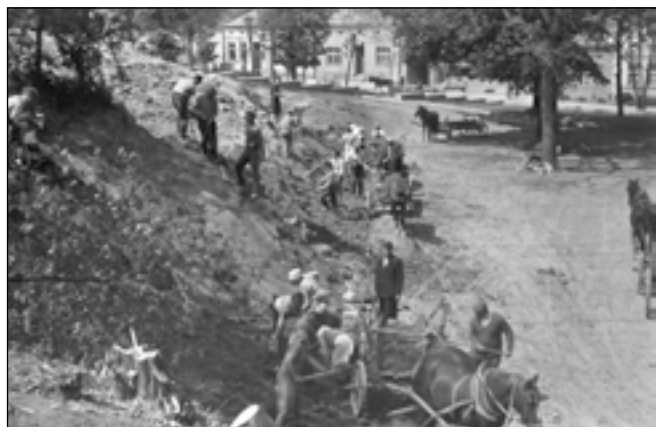
Prace ziemne przy kościele 1964 r.
