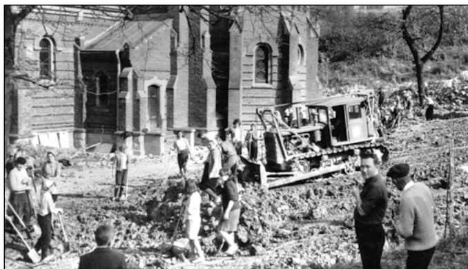
Do prac ziemnych użyto spychacza.
